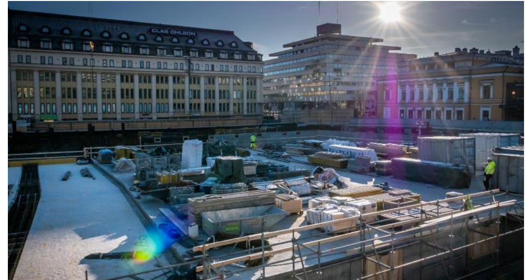
Torin alle rakennettiin aurinkoenergian keräysjärjestelmä. Kuva: Antero Lynne
