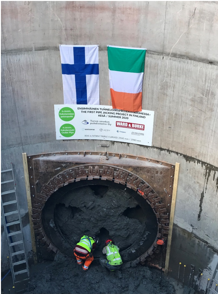
Kuva 2. Tunnelointikoneen (TBM) saapuminen lopetuskaivantoon 4.8.2020.
